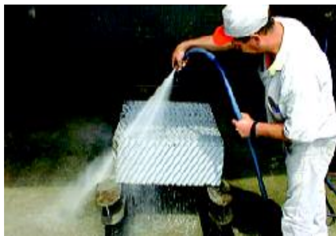
FIGURA 20 - Lavagem das placas coalescentes
