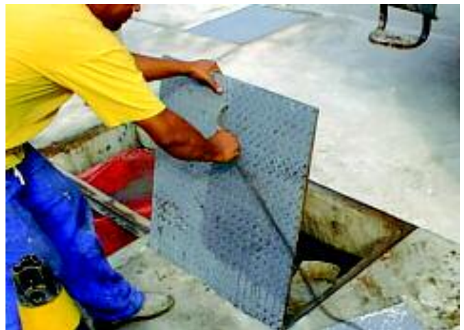
FIGURA 5 - Tampa de aço reforçada
