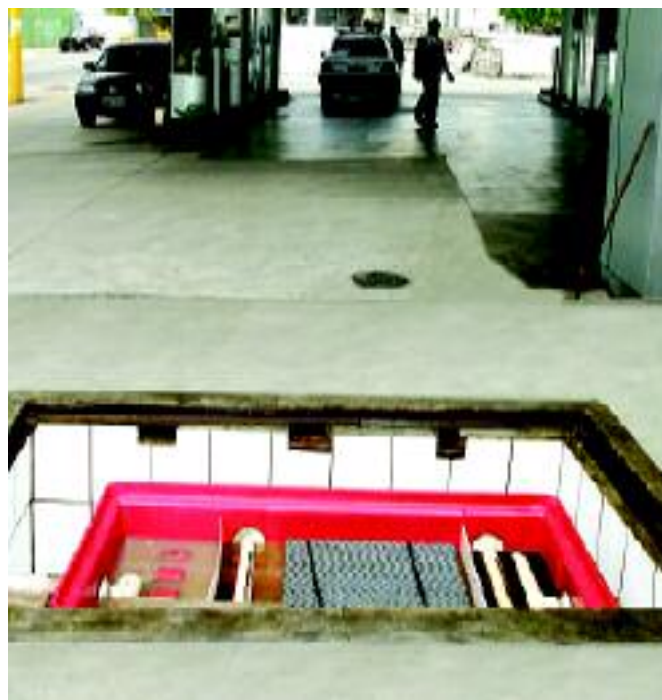
FIGURA 8 - Compartimento sob o piso
